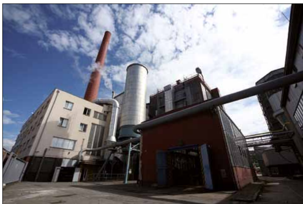
Obr. 1. Teplárna Náchod s celkovým instalovaným výkonem 118 MW t a 17 MW e dodává teplo do 929 odběrných míst
