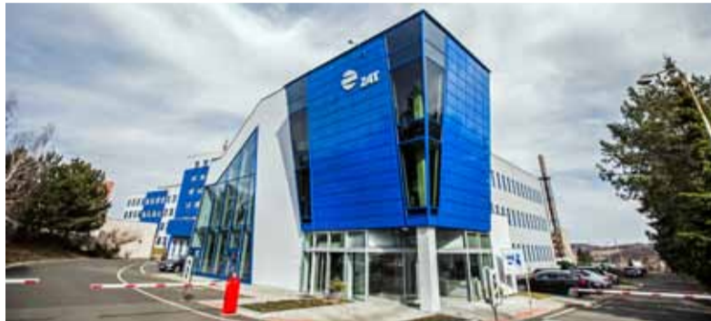
Do obnovy areálu a technologického zázemí v Příbrami za posledních pět let ZAT investoval téměř 140 mil. korun
