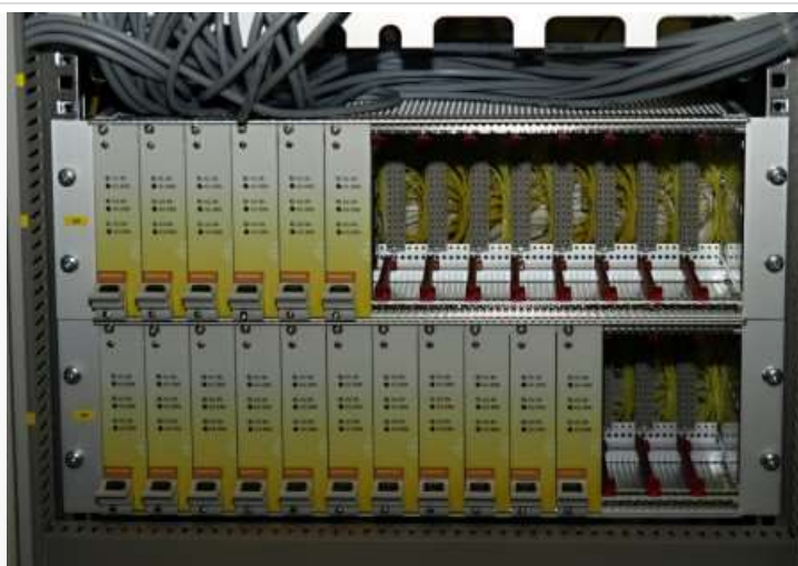
Řídicí systém bezpečnostní kategorie A je ve žluté barvě. (Zdroj: ZAT a. s.)
