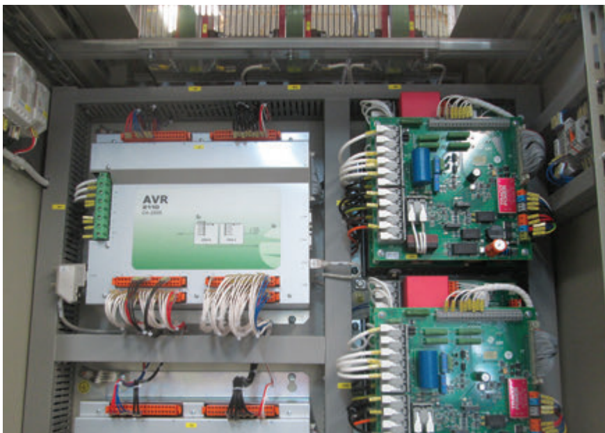
Řídicí a silová část budicí soupravy pro elektrárnu Vřesová
