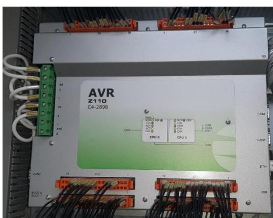
Automatický regulátor napětí AVR Z110 je proveden jako jednodeskový modul a obsahuje:
